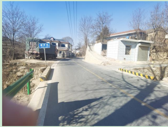
郭河村道路现状
